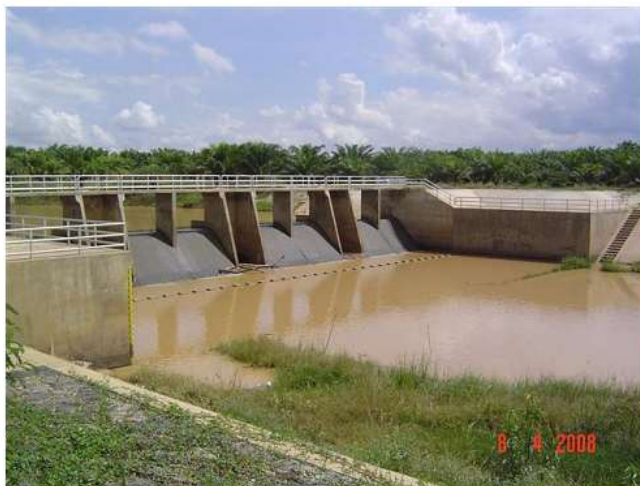
รูปภาพที่ ๕๐ ตัวอย่างฝายน้ำล้นสันมน ที่มา:สำนักงานการปฏิรูปที่ดินเพื่อเกษตรกรรม.(๒๕๖๑).
